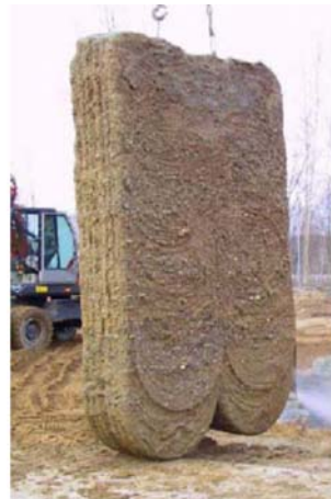
图 12-34 CSM 工法施工形成墙体
