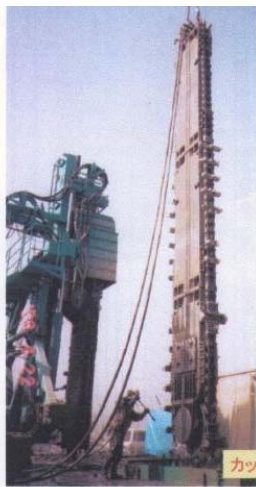
图 12-29 TRD 工法切削箱
