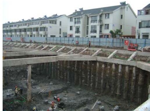
图 12-38 基坑开挖后实景图
