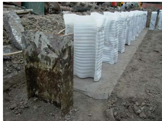
图 12-23 SMW 工法型钢与顶圈梁的连接
