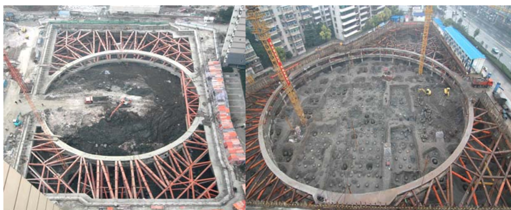
图 16-65 中石油基坑工程开挖全景
