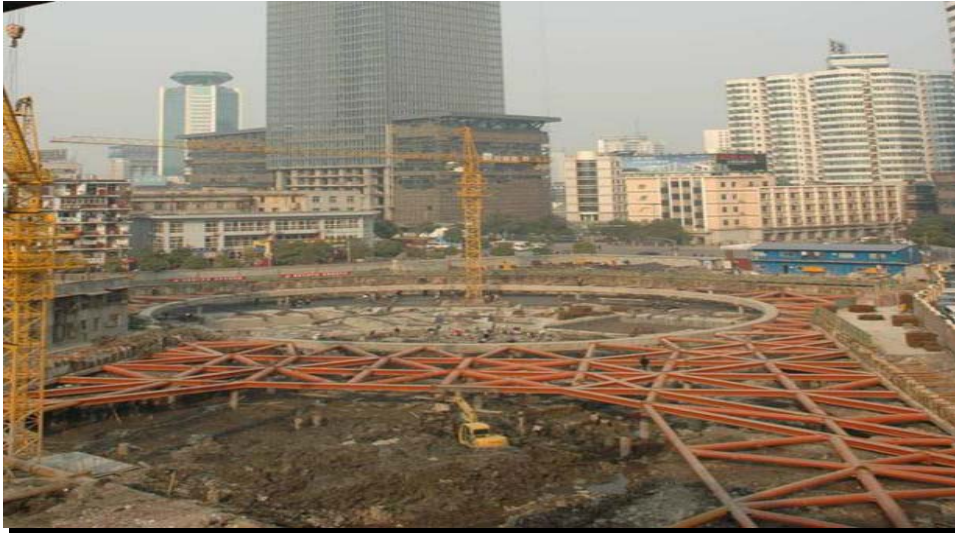
图 16-13 新华明珠基坑工程开挖全景
