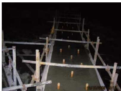
图 16-46 支撑浇筑时预留爆破孔
