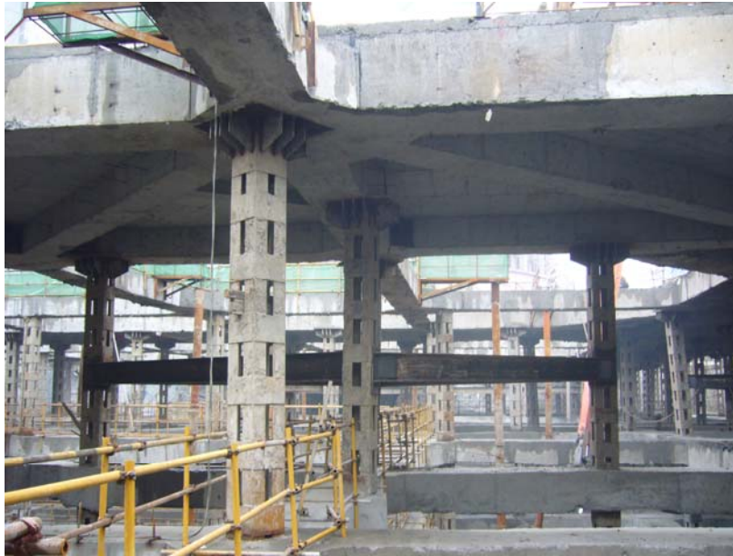
图 16-39 钢格构柱设置钢牛腿作为抗剪件的示意图与实景图
