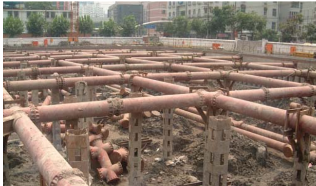
图 16-47 钢支撑施工
