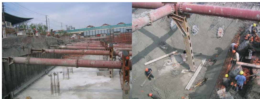
图 16-64 竖向钢斜撑实景
