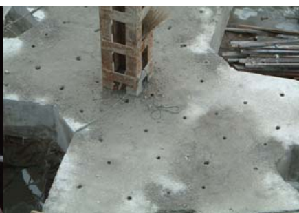
图 16-47 支撑浇筑形成时爆破孔实景
