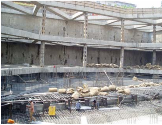
图 16-1 钢筋混凝土内支撑实景
