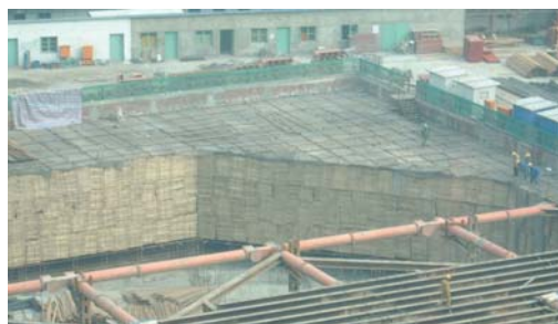
图 16-46 混凝土支撑爆破安全防护
