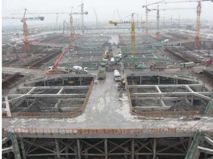
图 16-11 上海虹桥综合交通枢纽基坑支撑实景
