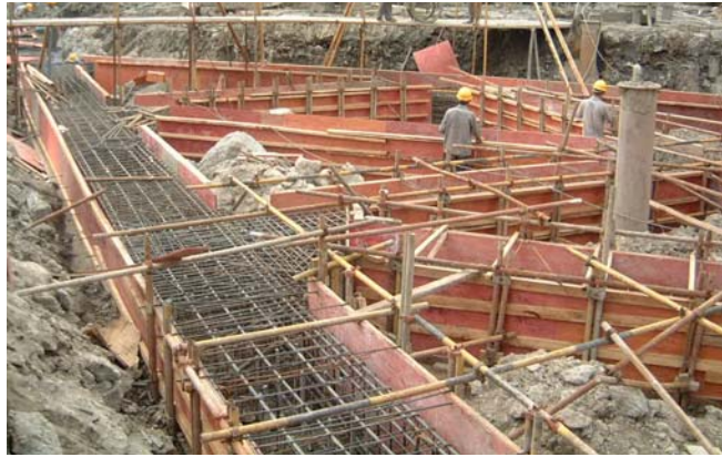
图 16-44 支撑模板现场实景
