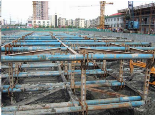
图 16-2 钢管内支撑实景
