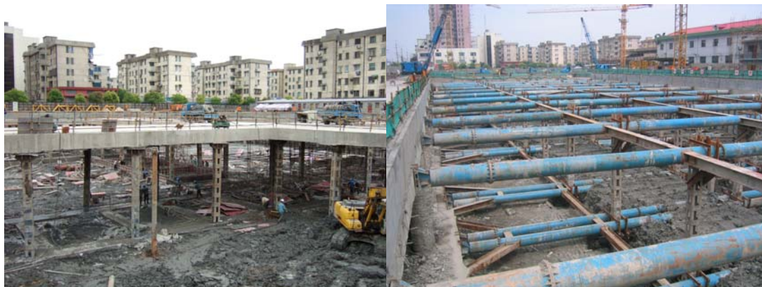
图 16-7 恒大小区东侧混凝土支撑实景
