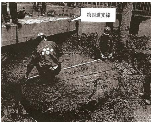
图 20-27 试验桩暴露开挖情况（深度 15~18m）
