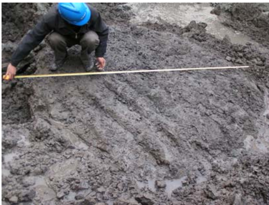
图 20-23 浅层旋喷桩开挖检验情况
