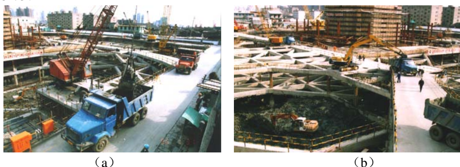
图 23-73 施工栈桥平台工程实景
