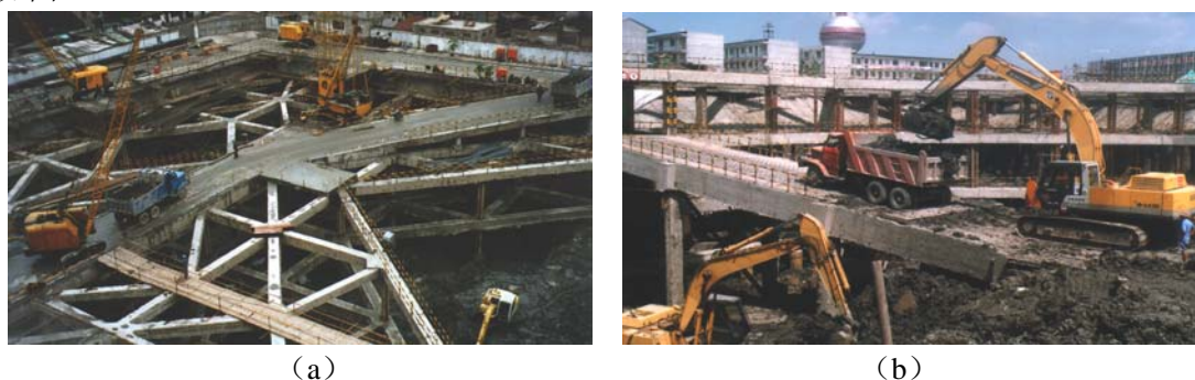
图 23-72 坑内栈桥道路工程实景
