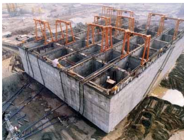
图 25-35 北锚沉井现场施工图
