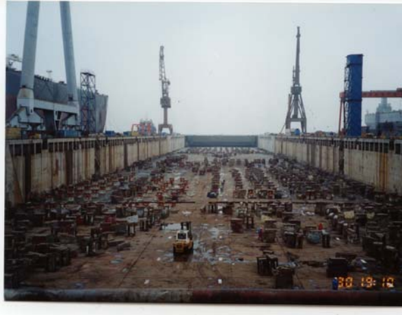
图 25-46 30万吨级造船坞实景
