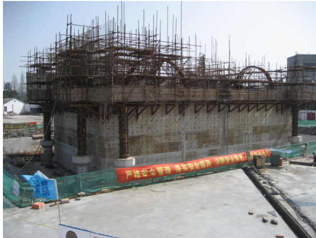
图 25-42 气压沉箱施工现场
