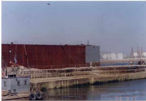
图 25-48 坞口大型钢浮箱
